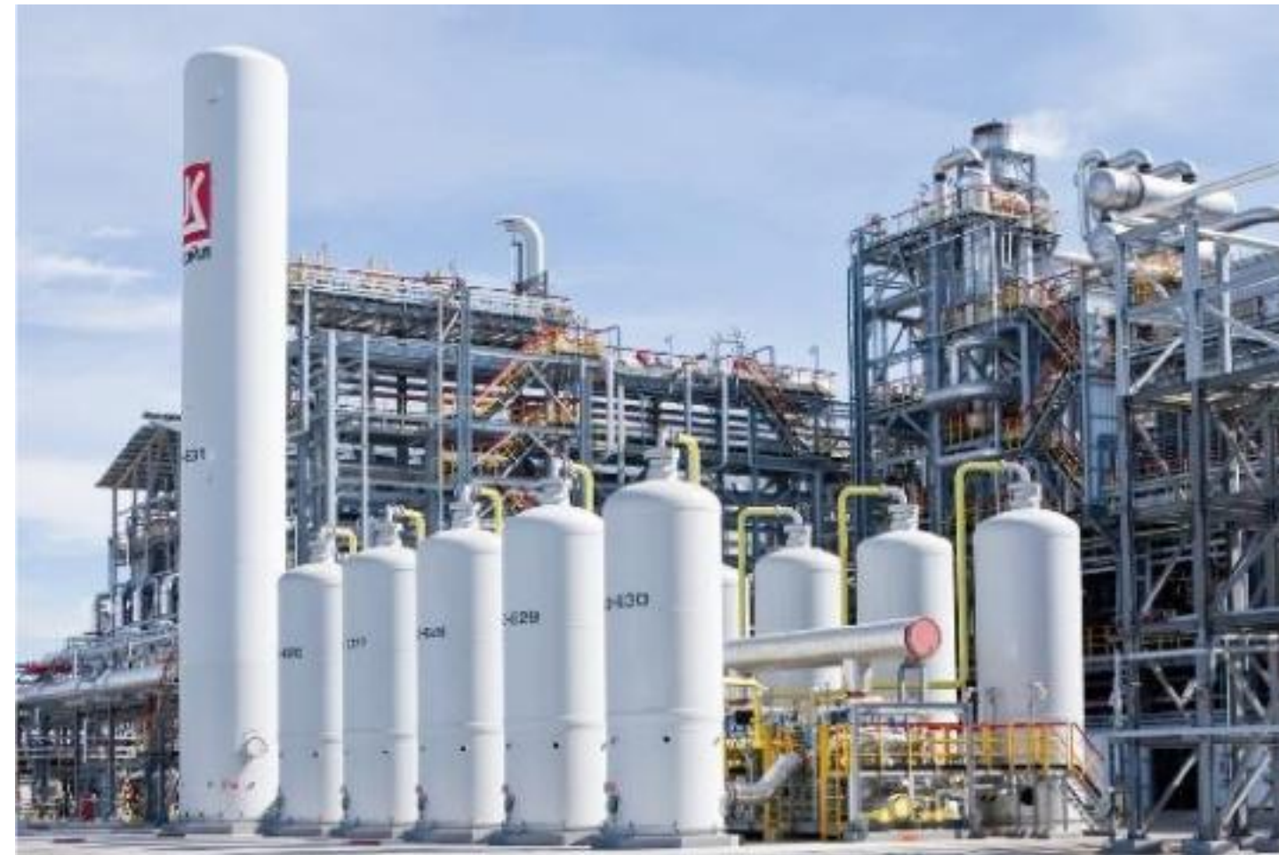
Комплекс по производству смазок и смазочно-охлаждающих жидкостей, г. Волгоград
