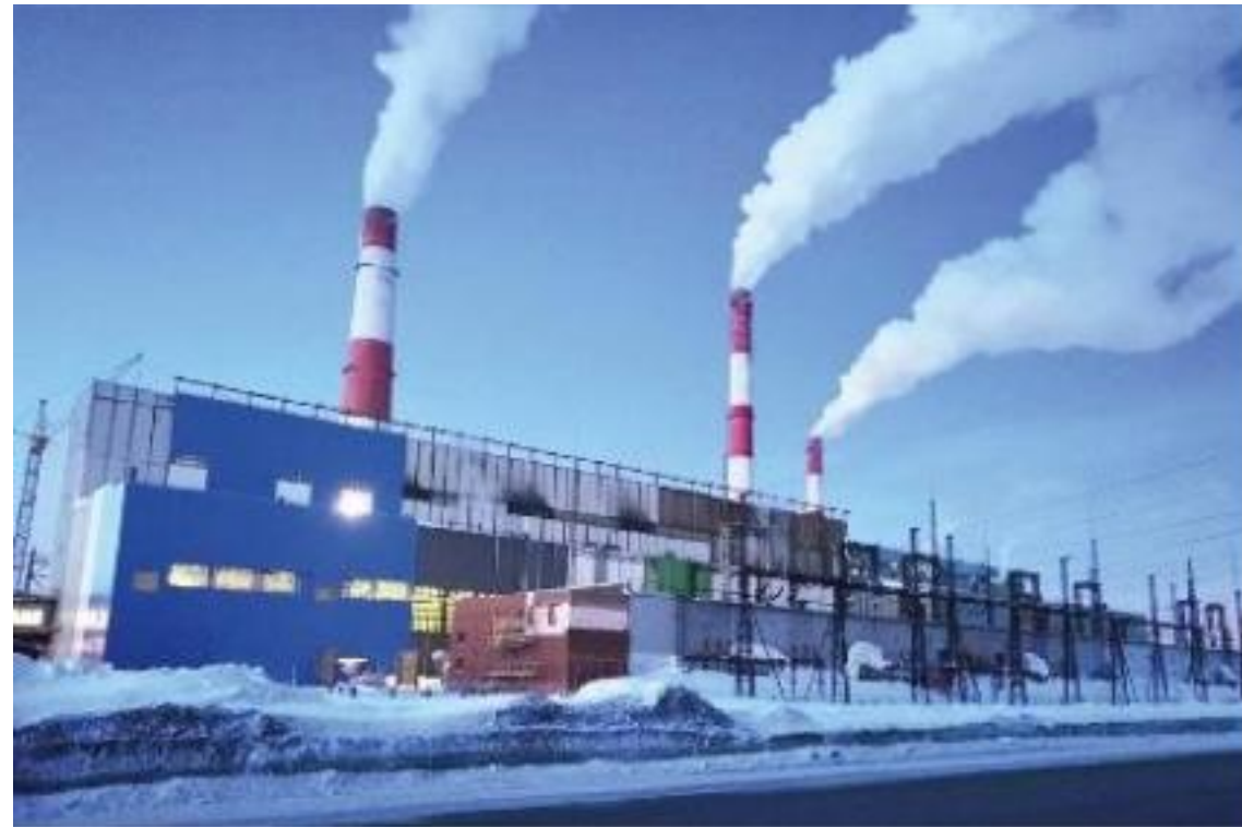
Газопоршневая электростанция Черногорская ТЭЦ «Русская платина»
